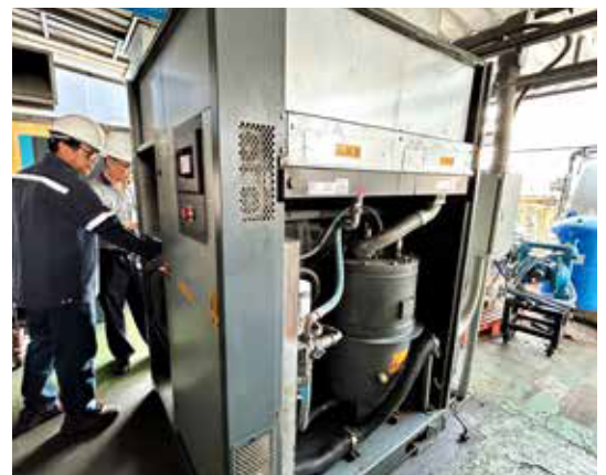
เครื่องอัดอากาศแบบสกรู Atlas Copco ที่โรงงานผลิตน้ำมันหล่อลื่น บริษัท เซฟรอน (ไทย) จำกัด
